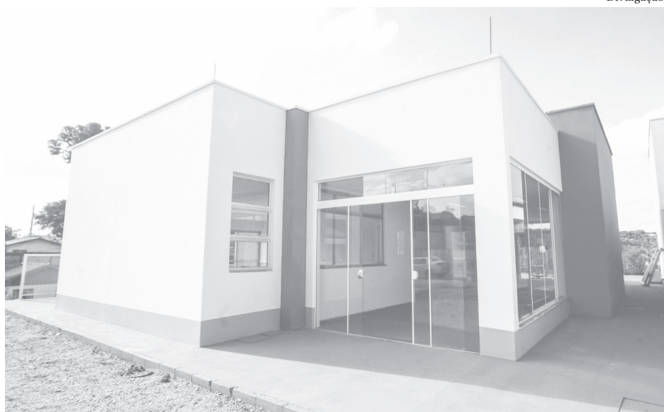
A ampliação da unidade escolar contou com a construção de um módulo de educação infantil
